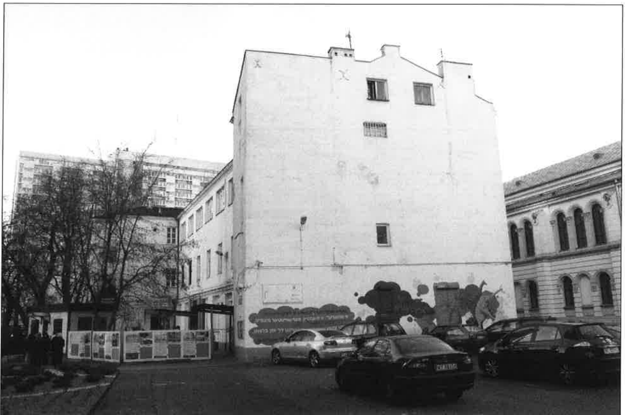
II. 4. Widok budynku od strony wschodniej.
