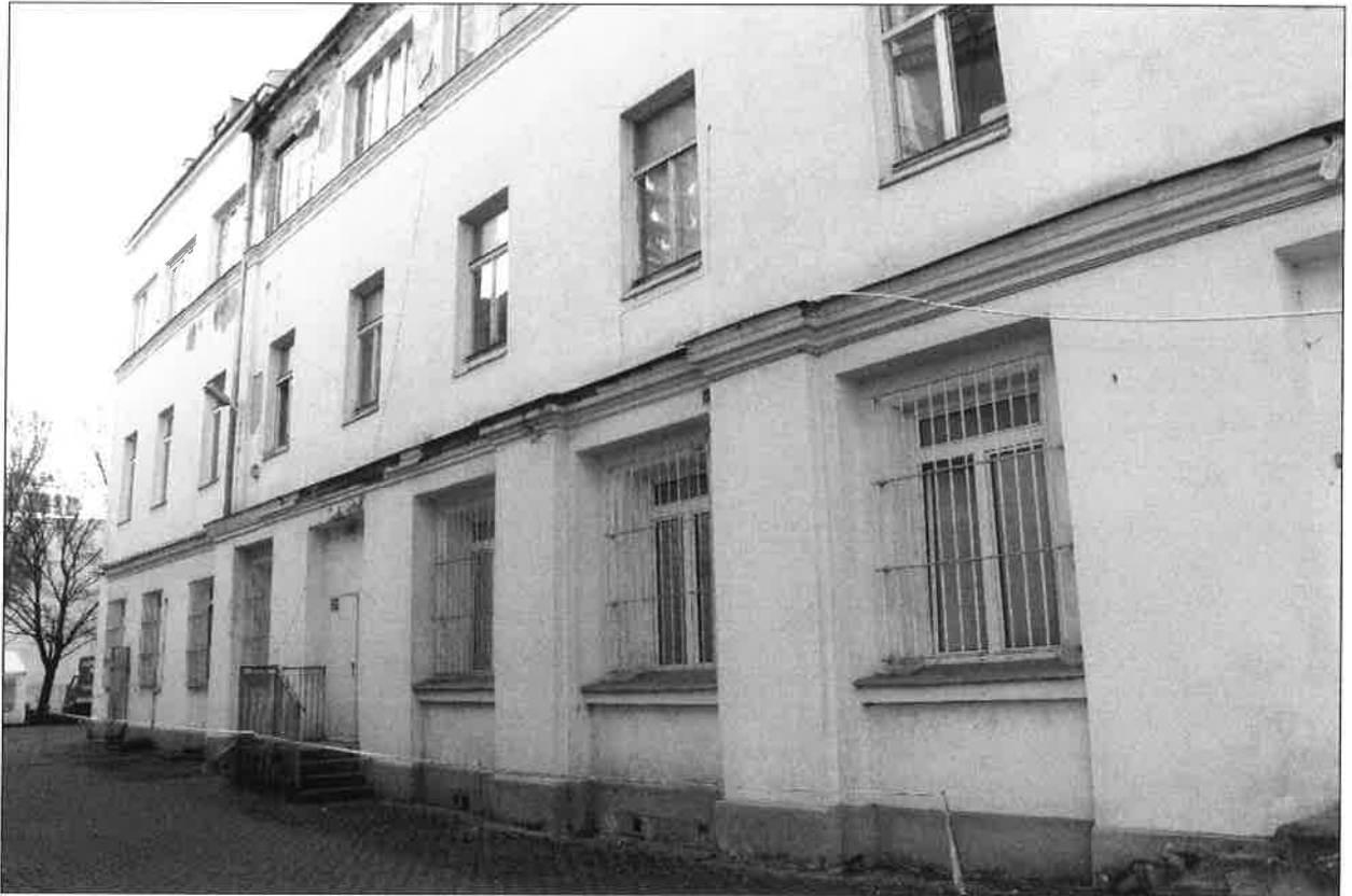
Il. 7. Widok elewacji północnej budynku.
