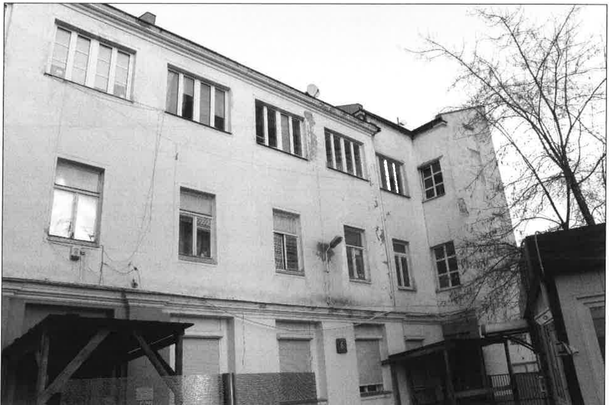
Il. 2. Widok części wschodniej elewacji południowej budynku.
