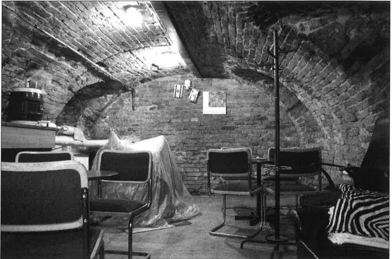
Il. 19. Widok wnętrza piwnic pod częścią wschodnią budynku.
