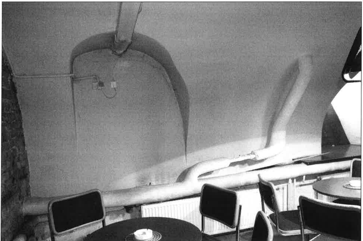
Il. 20. Widok wnętrza piwnic pod częścią wschodnią budynku.
