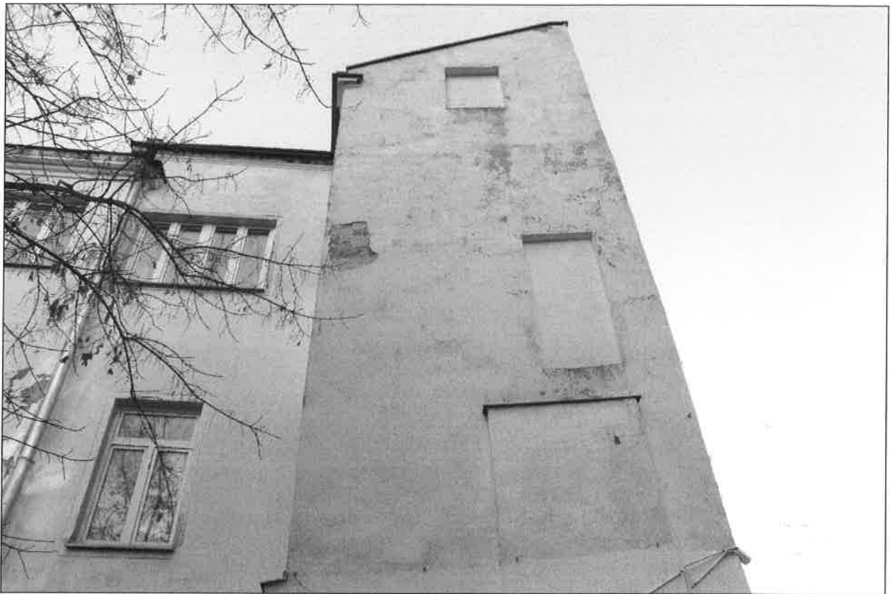
II. 3. Widok części wschodniej budynku.
