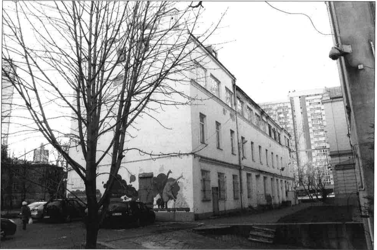
Il. 5. Widok budynku od strony północno - wschodniej.
