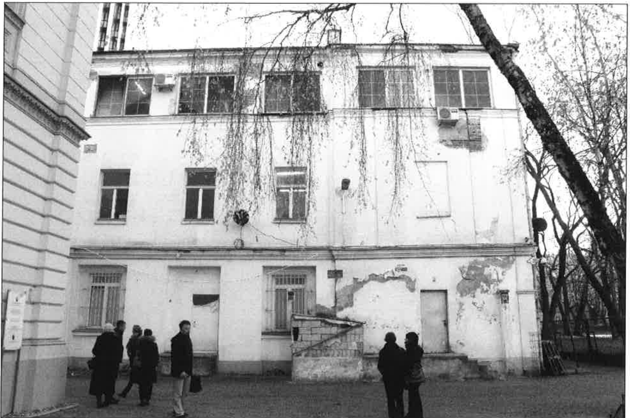
Il. 6. Widok części zachodniej elewacji północnej budynku.
