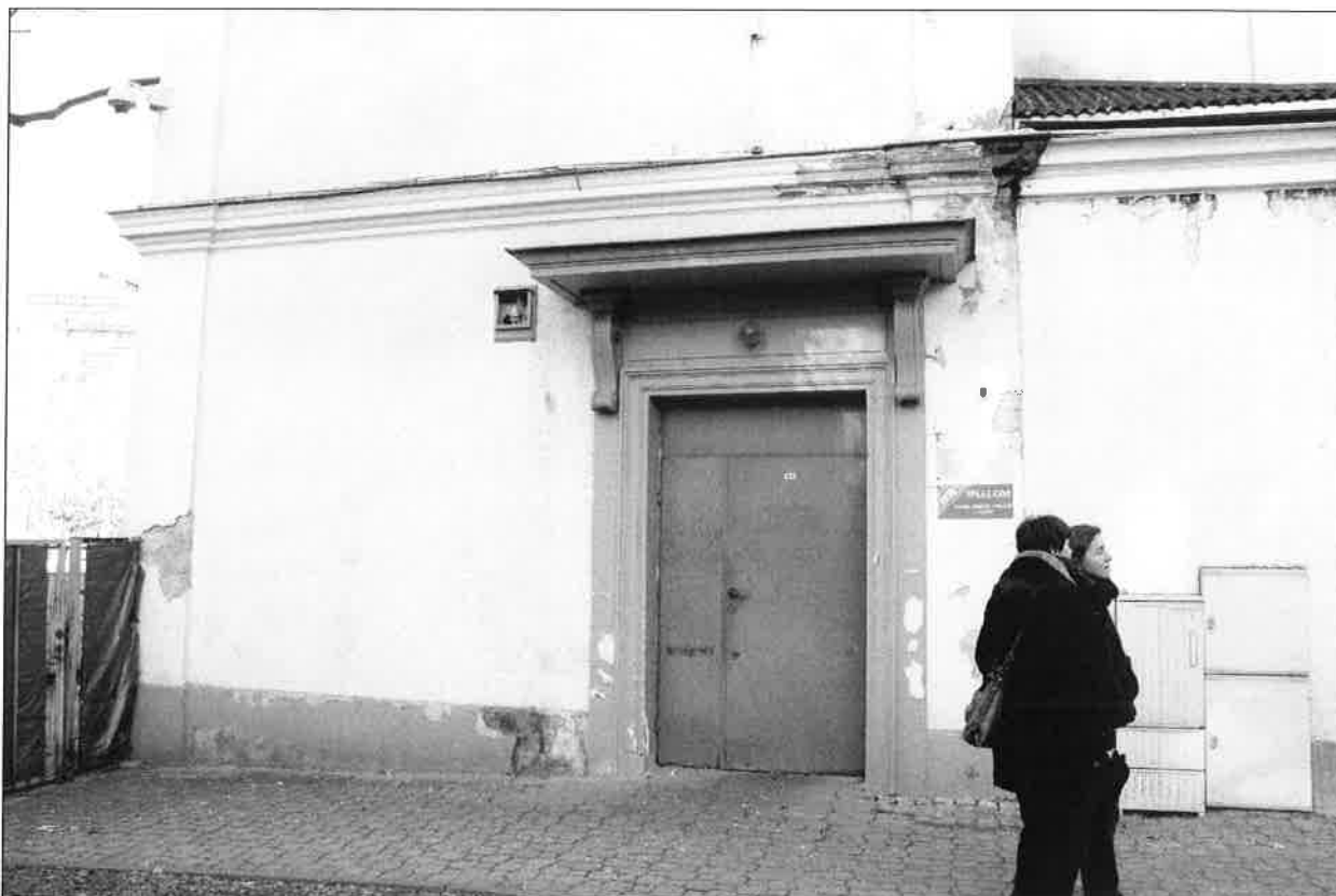
Il. 11. Widok wejścia do klatki schodowej w skrzydle zachodnim budynku.
