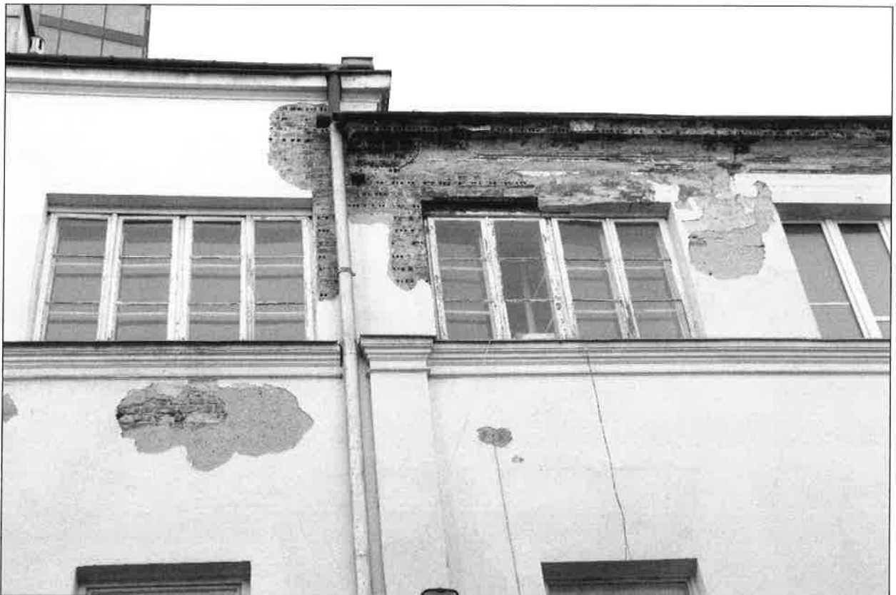
Il. 8. Widok trzeciej kondygnacji budynku od strony północnej.
