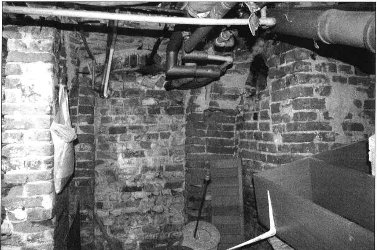
Il. 22. Widok wnętrza piwnic pod częścią wschodnią budynku.
