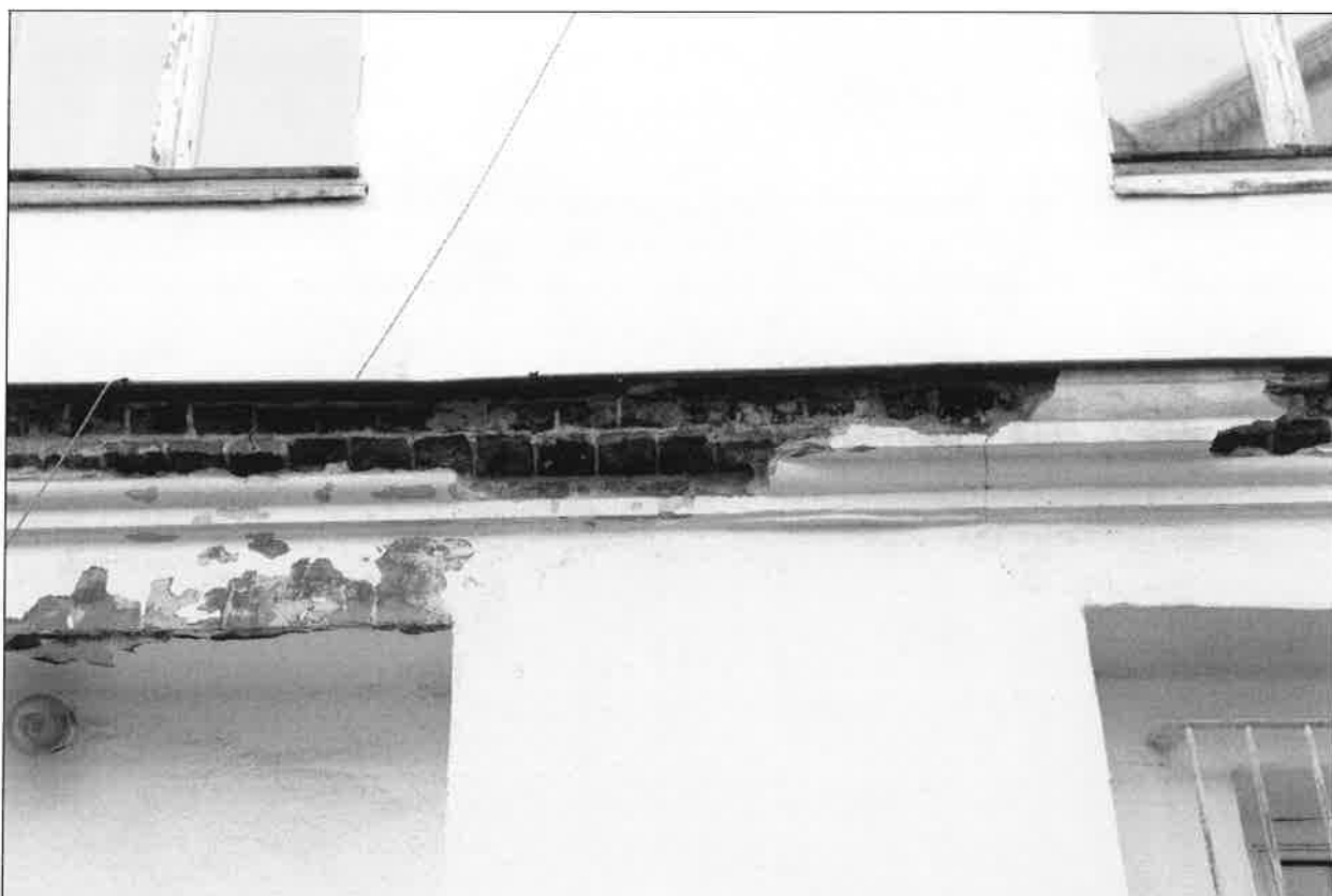
Il. 10. Widok konstrukcji gzymsu pośredniego w elewacji północnej budynku.
