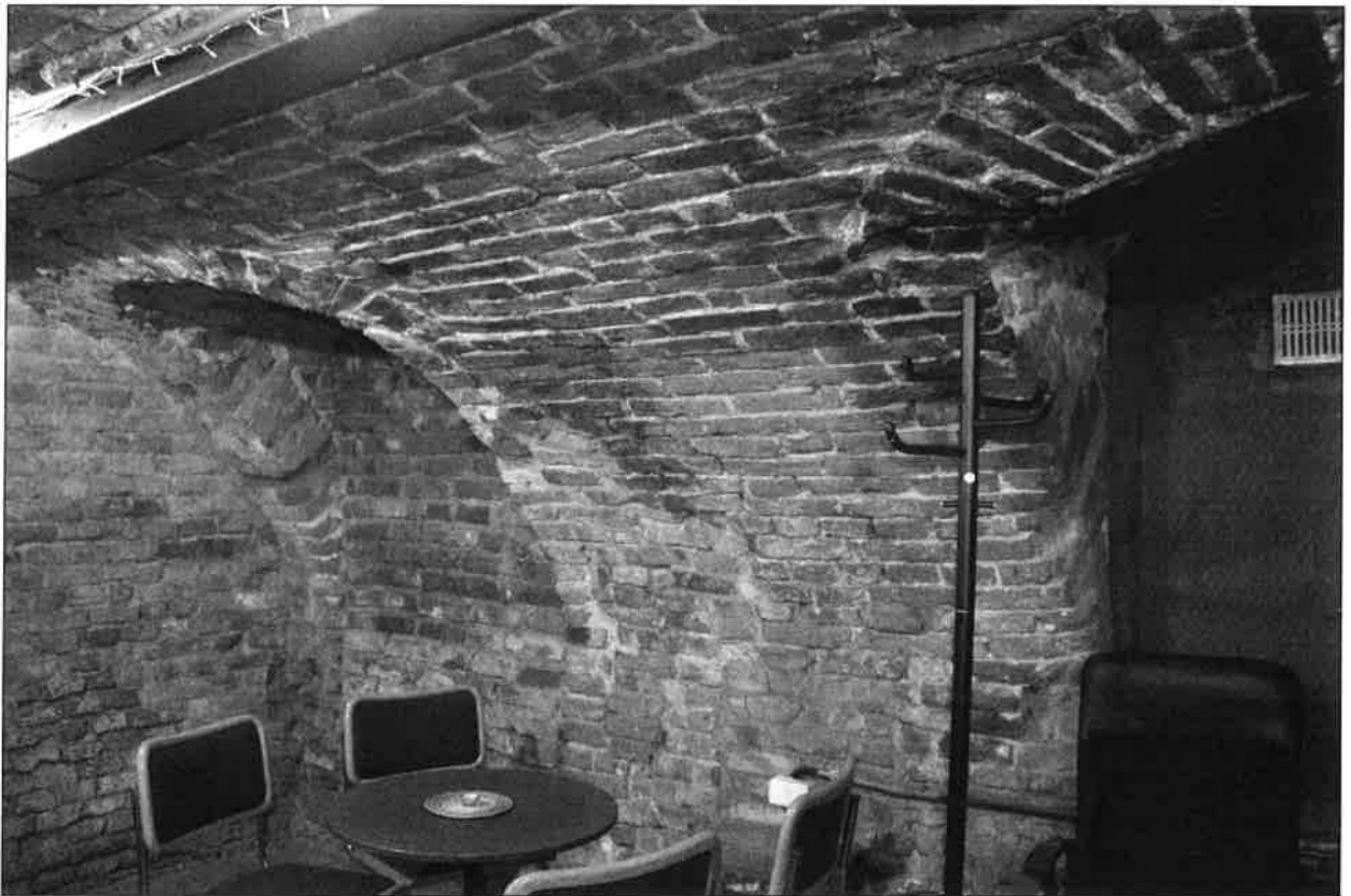
Il. 21. Widok wnętrza piwnic pod częścią wschodnią budynku.
