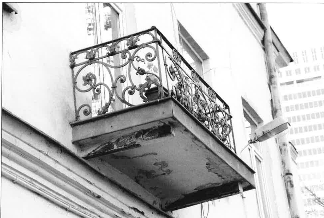
Il. 12. Balkon w elewacji zachodniej skrzydła zachodniego budynku.
